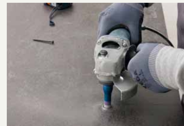
fig.25 / Pour obtenir des orifices de 4 à 12 mm, utiliser des mèches ou des forets de perceuse. Pour obtenir des diamètres supérieurs, utiliser des scies-trépan diamantées à appliquer à la ponceuse, que nous pouvons utiliser pour les perçages tant à l'eau qu'à sec. Nous suggérons cependant de choisir le perçage à l'eau : pour ce faire, il suffit de pulvériser de l'eau sur la zone concernée ou d'utiliser des outils prévus à cet effet. Nous conseillons de ne pas utiliser de perceuse manuel. / Für Löcher mit einem Durchmesser von 4 bis 12 mm Bohrspitzen oder Stichsäge verwenden. Für größere Durchmesser Diamantbohrkronen auf einer Schleifmaschine verwenden, die man sowohl im Trocken- als auch im Nassbetrieb verwenden kann. Es wird jedoch empfohlen, den Nassbetrieb vorzuziehen: Es genügt hierfür den Bereich zu befeuchten oder entsprechende Geräte für den Nassbetrieb zu verwenden. Keinen normalen Schlagbolzen verwenden.
