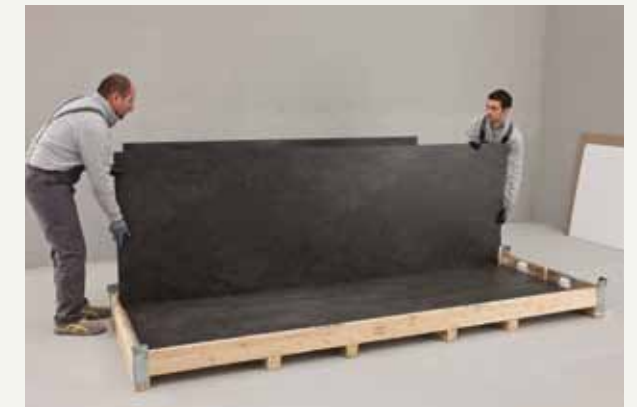
fig.6 / Déplacer la plaque, avec l'aide d'un deuxième opérateur, en la maintenant toujours perpendiculaire au sol, en évitant toute flexion et en protégeant les angles contre tout choc accidentel. / Die Platte mit Hilfe einer zweiten Person tragen, sie dabei immer vertikal zum Boden halten, um Verbiegungen zu vermeiden und die Ecken vor unbeabsichtigten Stößen zu schützen.
